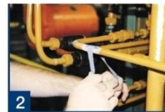
2 Farbe entfernen und Rohr reinigen
