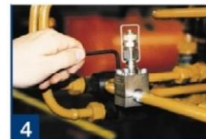
4 Messanschluss verschrauben
